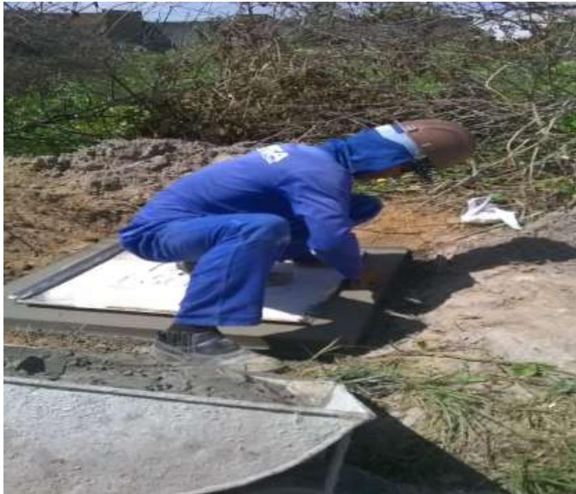
**Figura 08. Pedreiro fazendo reboco de uma caixa de esgoto**
