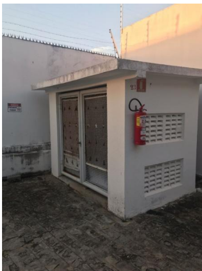
FIGURA 5 – Depósito interno: Casa de Descartes.
