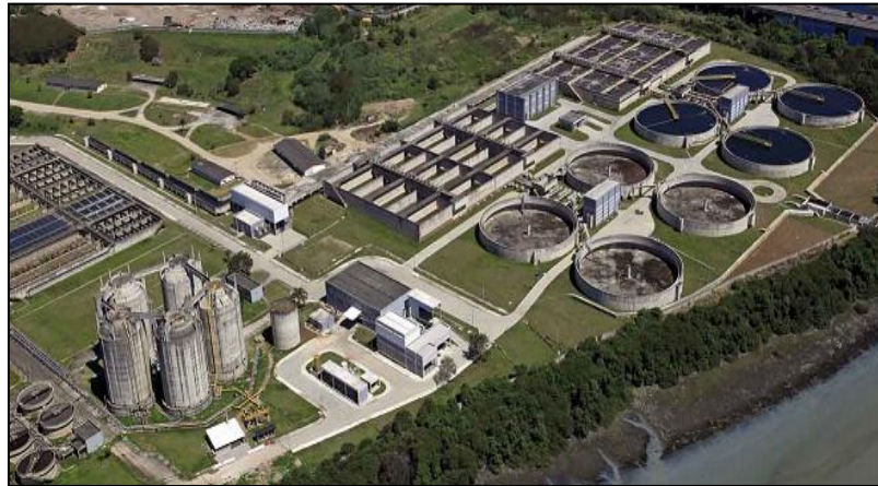
Figura 3- Estação de tratamento de esgoto (ETE). Fonte: ENGEFORM (2016).
