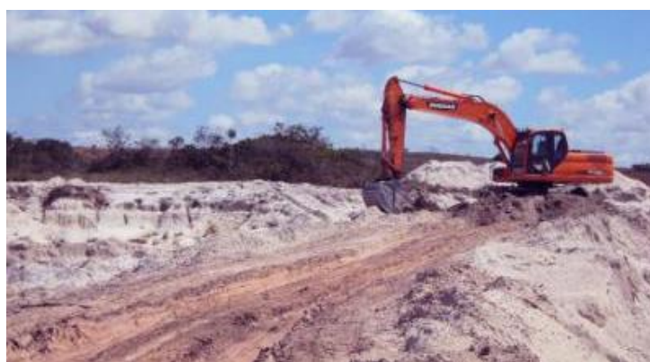
Figura 2: Mineração a céu aberto de areia com o uso de retroescavadeira.
