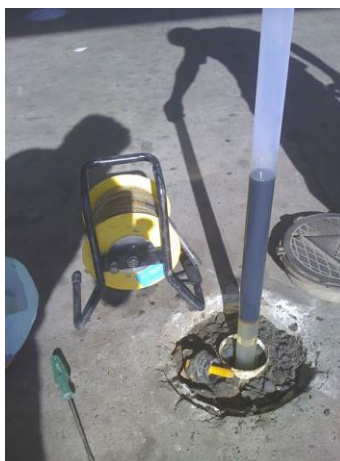
Figura 09: Poço de monitoramento
