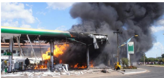
Figura 04: Incêndio em posto de Combustível.
