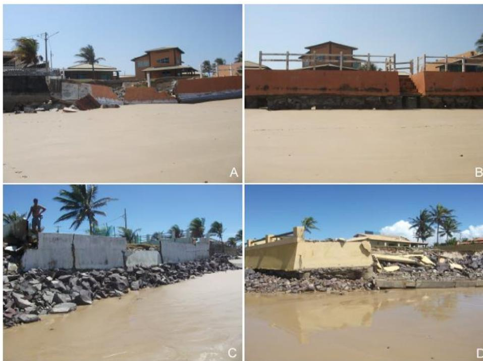
**Figura 4:** Medidas de Contenção adotadas pelas residências. Paredão de rochas. A – Situação das Casa no trecho apresentado após fenômeno de ressaca; B- Condição Inicial; C – Muro de Pedras Artificial como forma de Contenção Emergencial ; D – Situação do Muro de Pedra após novo Fenômeno de Ressaca.
