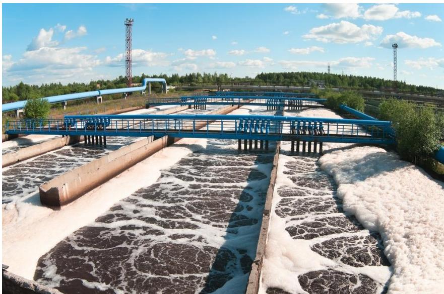
Figura 1 – Reator aeróbio. Fonte: [www.fusati.com.br](http://www.fusati.com.br) (2015).
