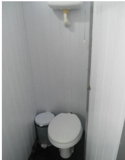
Figura 8 - Vestiário do projeto piloto de uma usina.
