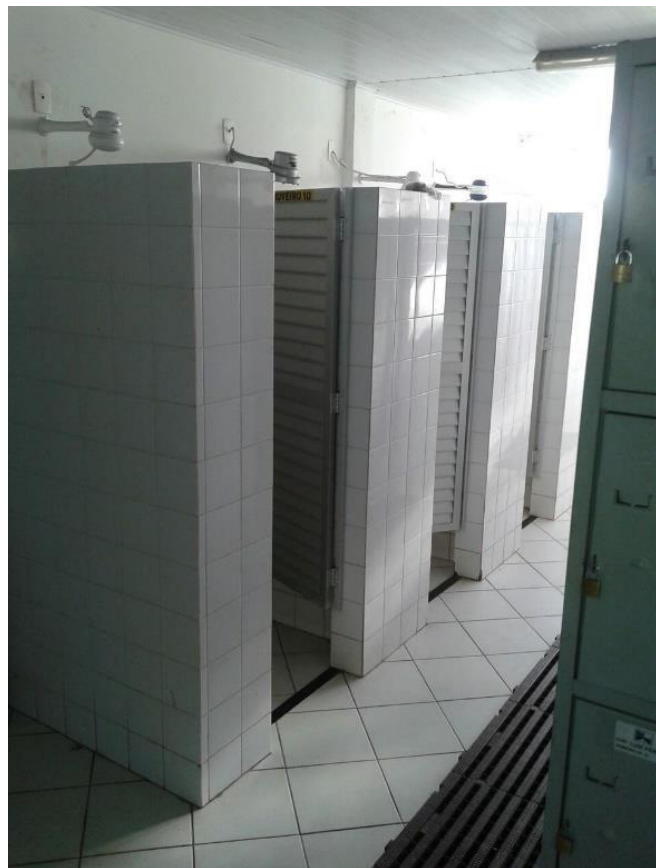
Figura 34 - Área de chuveiros do canteiro das contratadas de uma distribuidora de petróleo
