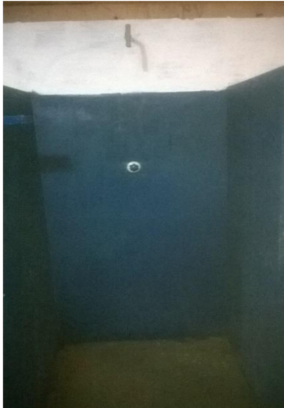
Figura 23 - Área de chuveiros em uma empresa construção civil.
