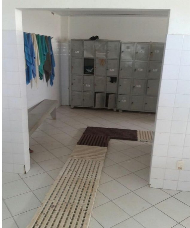
Figura 35 - Vestiário do canteiro das contratadas de uma distribuidora de petróleo
