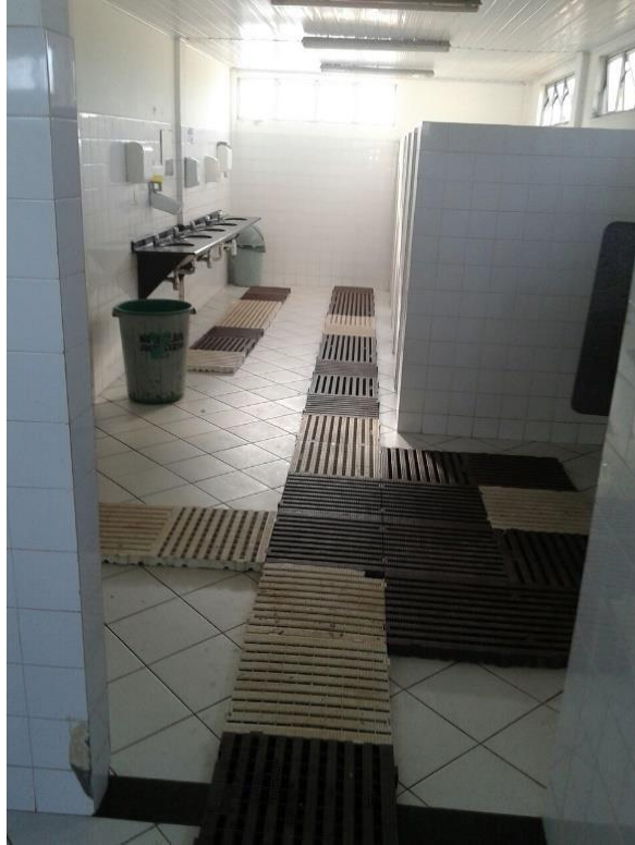
Figura 31 - Instalação sanitária do canteiro das contratadas de uma distribuidora de petróleo
