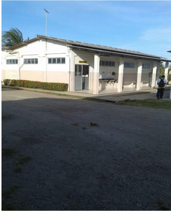
Figura 29 - Refeitório do canteiro das contratadas de uma distribuidora de petróleo.
