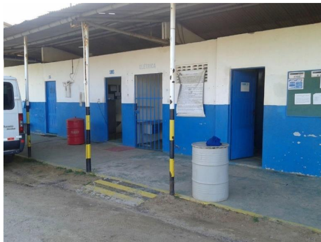
Figura 28 - Área administrativa do canteiro das contratadas de uma distribuidora de petróleo.
