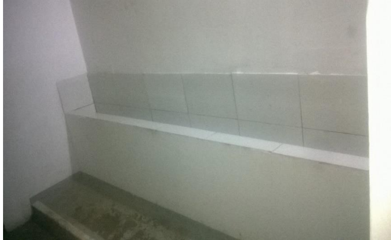
Figura 27 - Mictórios em uma empresa construção civil
