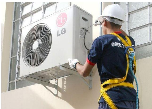
Figura 1: Realização de manutenção em um condensador.
