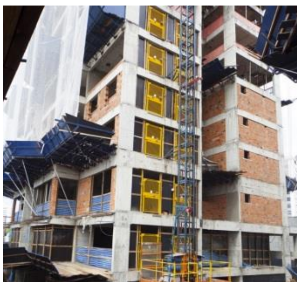
Figura 7 - Medidas de segurança durante a execução da obra.
