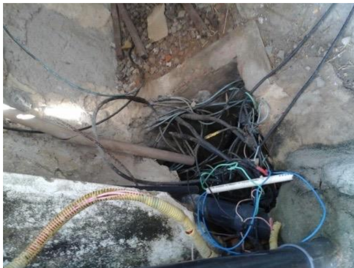
Figura 4: Caixa de passagem com livre acesso no Posto Z, em são Cristóvão.
