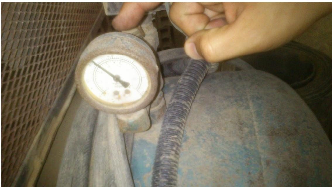
Figura 3 – Equipamento apresentando sinais de ferrugem evidenciando falta de manutenção
