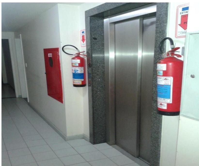
Figura 03 – Extintores de incêndio em todos os corredores do Edifício residência e sistema de hidrantes de combate a incêndio.
