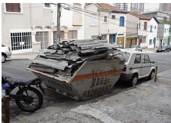
Figura 6: Caixas coletoras de entulho contendo telhas de cimento-amianto.
