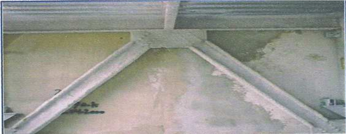
Figura 4 – Argamassa à base de Vermiculita
