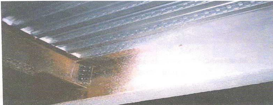
Figura 5 – Argamassa Cimentícia de Baixa Densidade (MENDES, 2004, [n.p.])
