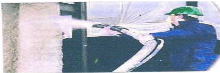
Figura 8 – Aplicação de Fibra Projetada em uma coluna
