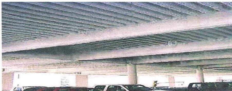
Figura 9 –Detalhe após a aplicação de Fibra Projetada
