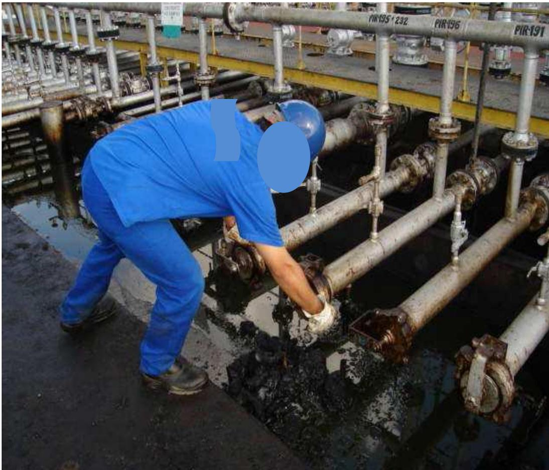
**Figura 04.** Postura do operador abrindo o tampão da câmara de raspador.
