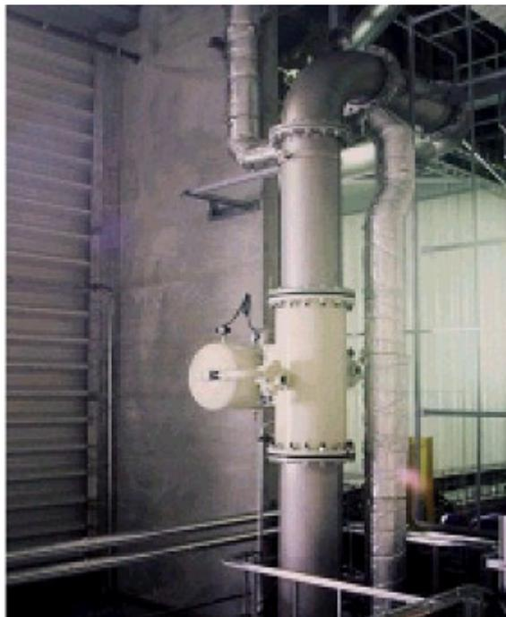
Figura 4. Válvula de isolamento
