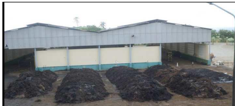
Figura 23 - Pátio de secagem externa
