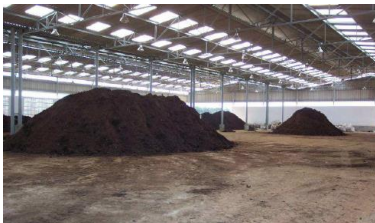
Figura 24 - Pilhas arrumadas internas
