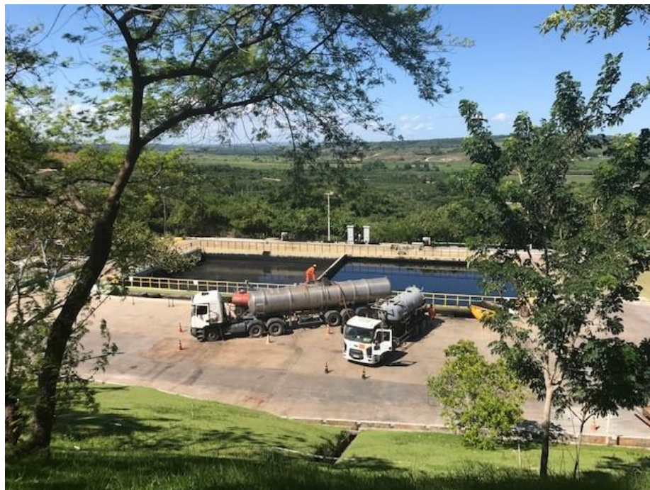
Figura 18 - Descarregamento de fluido
