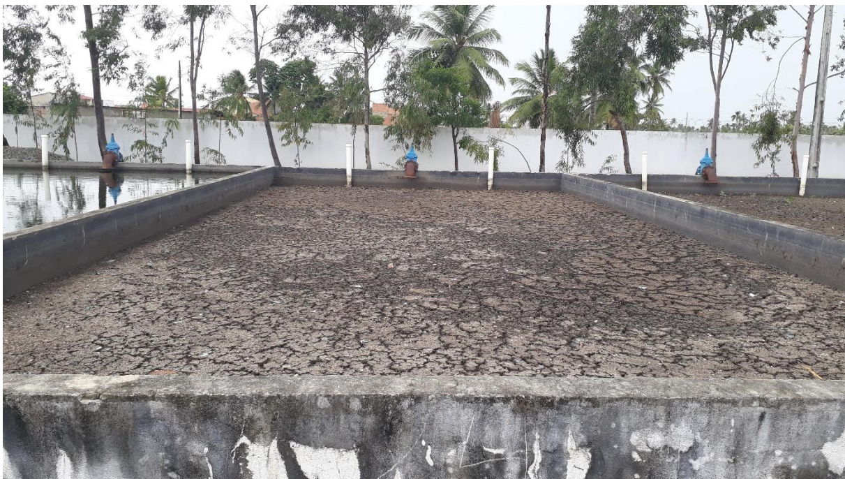
Figura 9 – Leito de secagem de uma ETE
