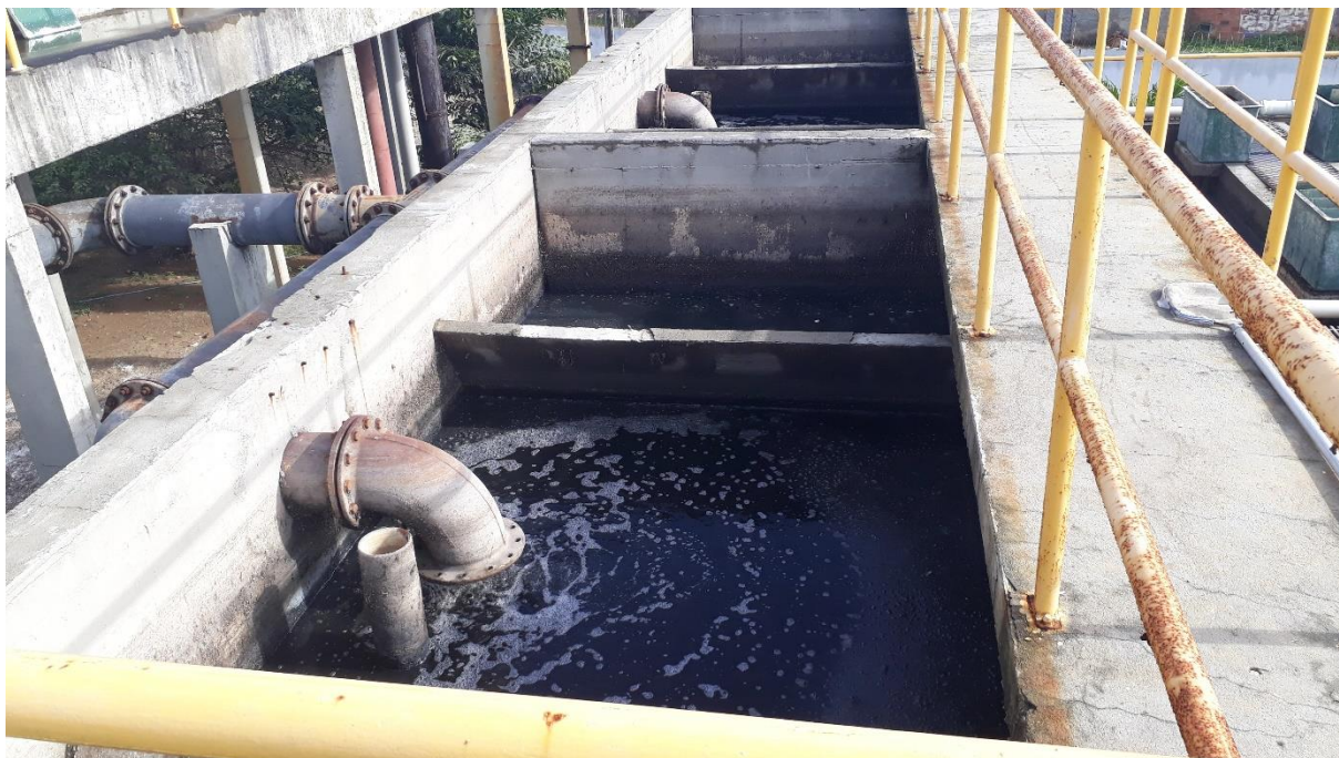
Figura 6 – Câmara de carga de uma estação de tratamento de esgoto
