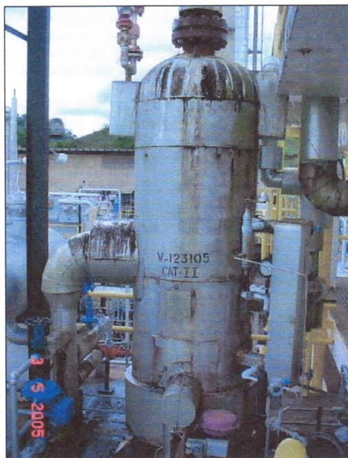
Figura 25 –Vaso expansor de propano V-123105
