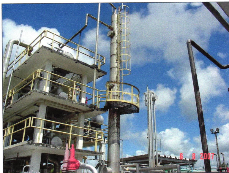
Figura 27 – Torre desetanizadora de LGN: T-123101
