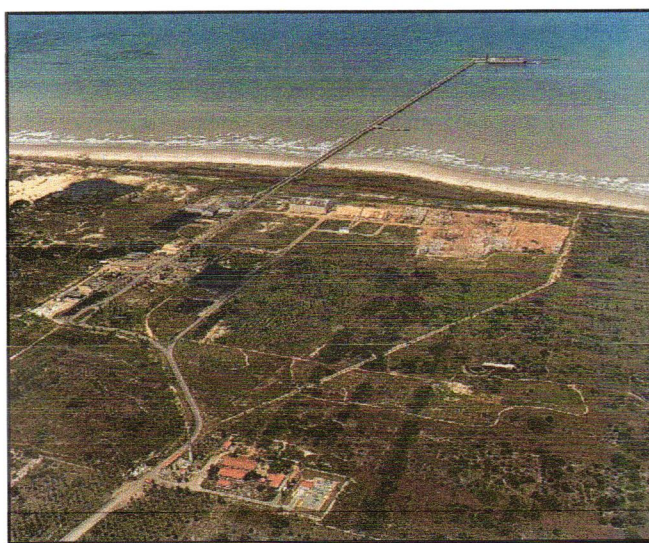
Figura 16 - Foto do Terminal Marítimo Inácio Barbosa (TMIB).
