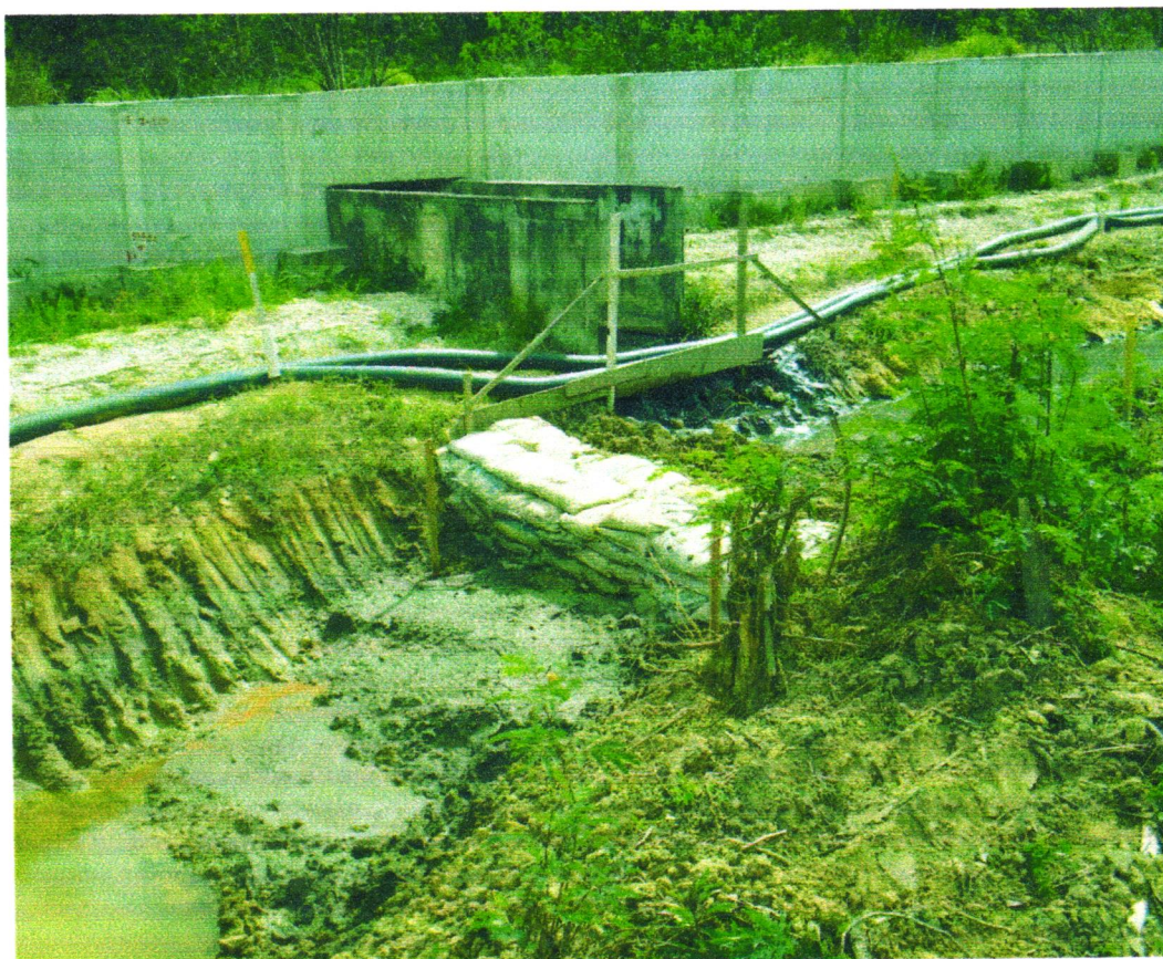
Figura14 – Colocação de enssacadeira no canal de minério Fonte – Vale (2008)
