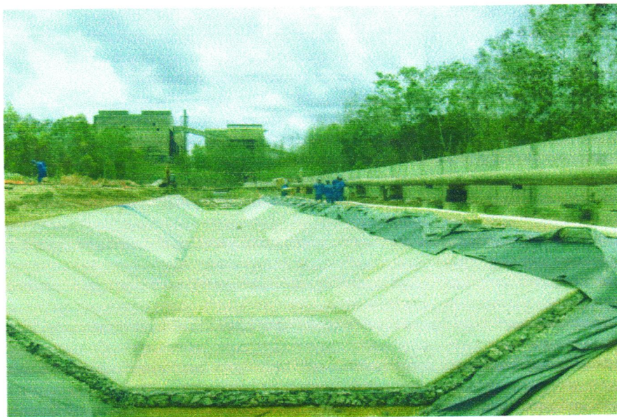
Figura 23 – Aplicação de argamassa no canal Fonte – Vale (2008)
