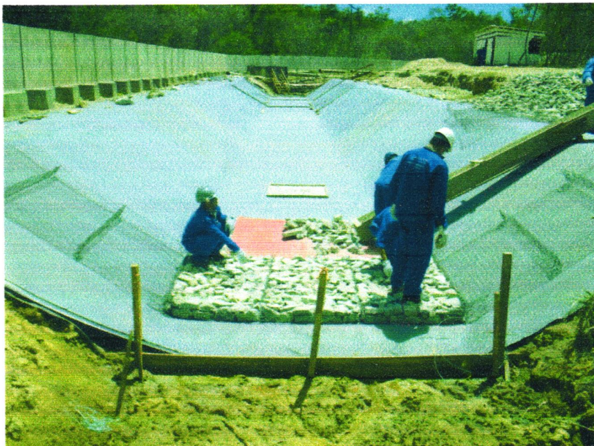
Figura 21 – Terceira camada de filtro geotextil Fonte – Vale (2008)
