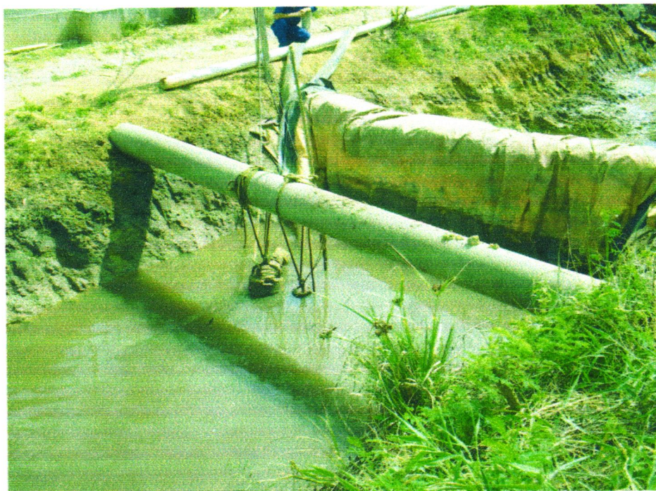
Figura 15 – Colocação de bombas no canal Fonte – Vale ( 2008)
