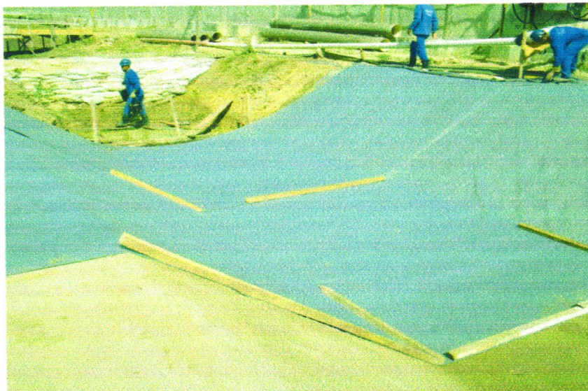
Figura 19 – Primeira e Segunda aplicação do filtro geotextil no canal Fonte – Vale (2008)
