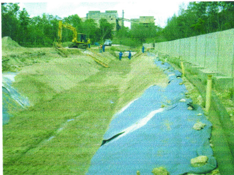
Figura 17 – Colocação de areia adensada no canal Fonte – Vale (2008)
