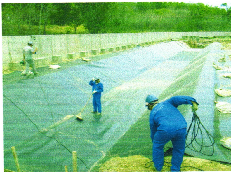
Figura 20 – Fixação da manta Fonte – Vale (2008)
