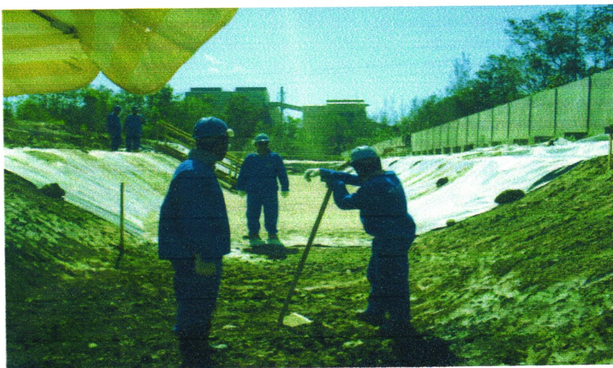
Figura 18 – Regularização de solo do canal Fonte – Vale (2008)
