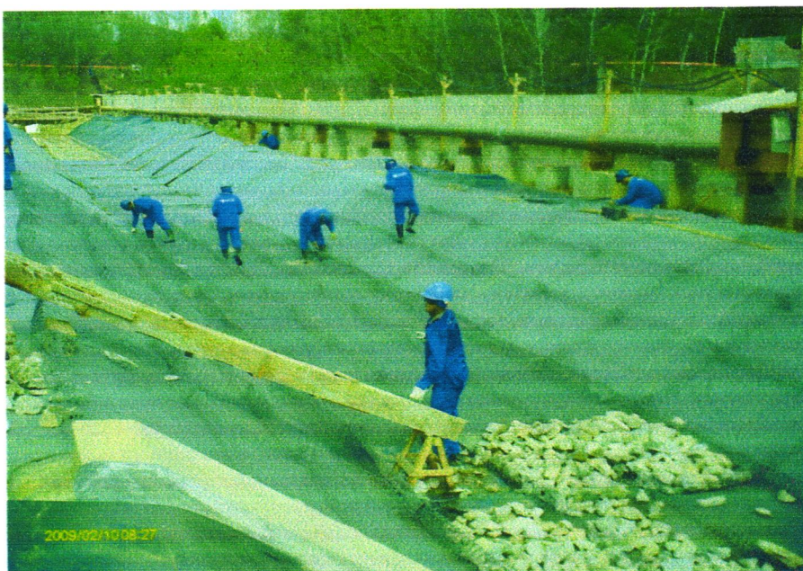
Figura 22 – Montagem de colchão reno Fonte – Vale (2008)
