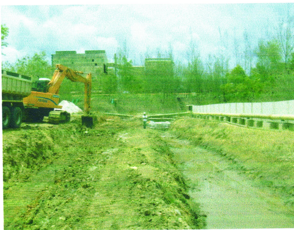
Figura 13 – Início da escavação da canal Fonte – Vale (2008)
