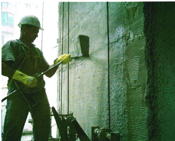
Figura 5 – Aplicação de argamassa Fonte: ANVI (2009)
