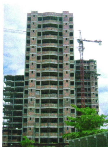
Figura 8 – Alvenaria executada Fonte: Autor da Pesquisa (2009)
