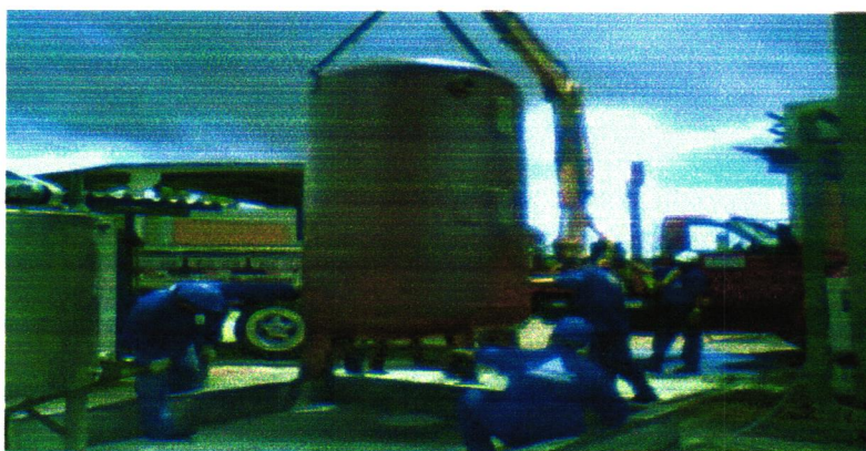
Figura 5 - Montagem de abrandador para tratamento de água.
