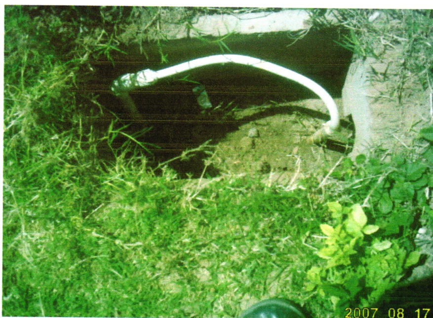
Figura 11: hidrômetro retirado pelo cliente sem autorização. Fonte : Companhia de Saneamento de Sergipe
