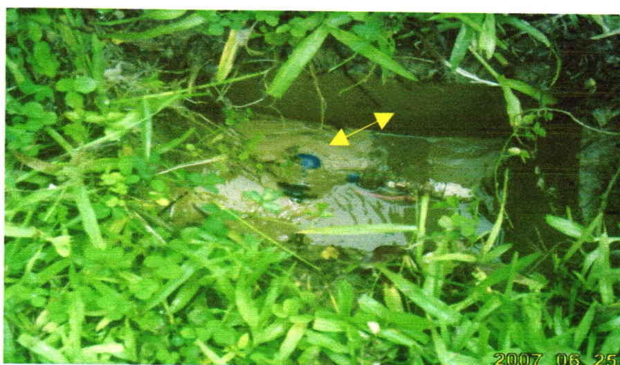
Figura 06: hidrômetro imerso em lamas na periferia da cidade de Aracaju Fonte: Companhia de Saneamento de Sergipe
