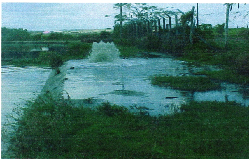
Figura 13: Duto geral estourado na periferia da cidade de Aracaju Fonte: Companhia de Saneamento de Sergipe
