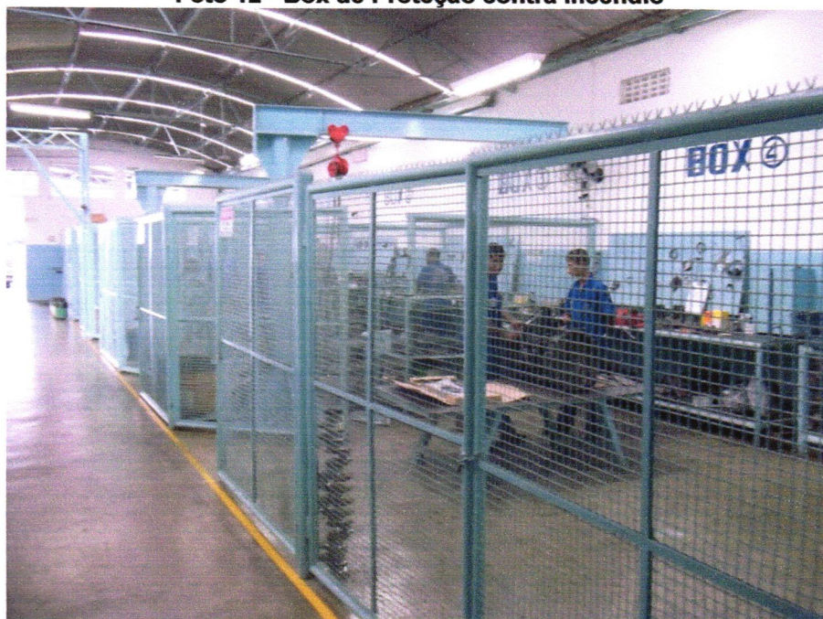
Foto 12- Box de Proteção contra incêndio
