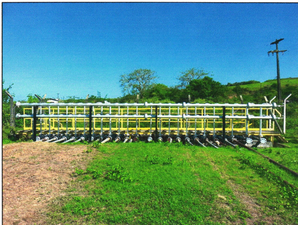
Figura 20 - Satélite que recebe o óleo proveniente dos poços (1).
