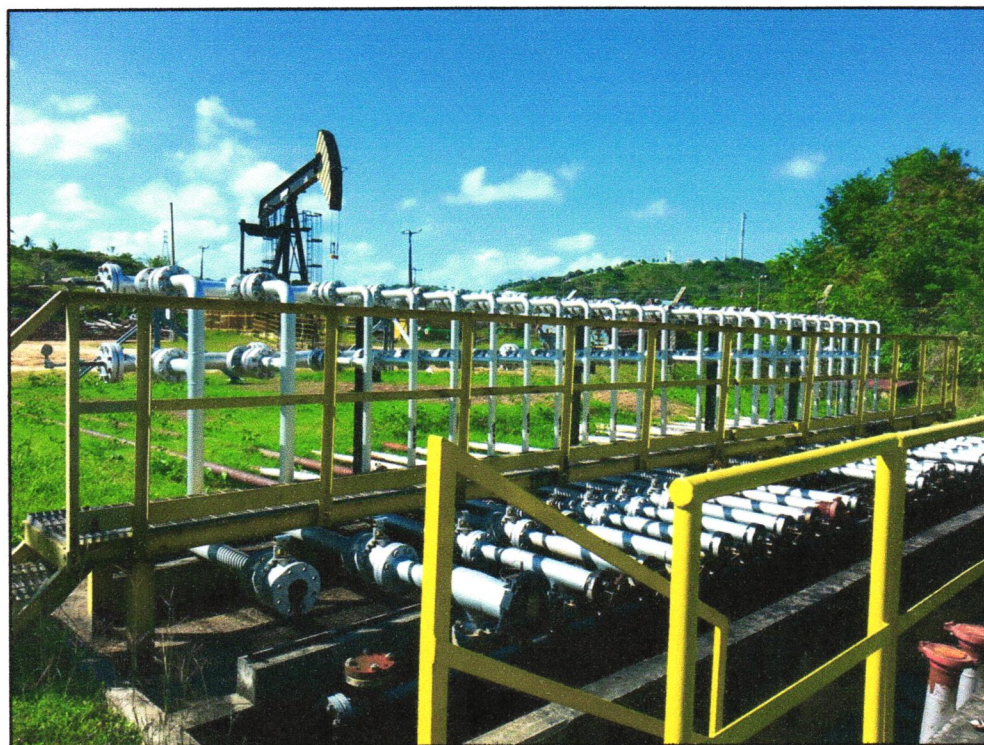
Figura 21 - Satélite que recebe o óleo proveniente dos poços (2).
