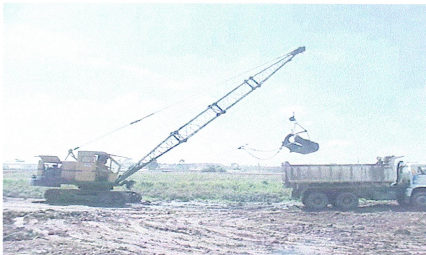
Figura 3 – Carregamento de caçambas com escavadeira equipadas com Clam – Shell (Rio Acre/ AC)
