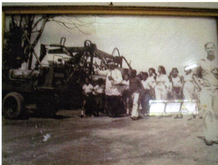
Figura 2 – Foto resgatada, mostrando a benção aos trabalhadores e aos novos tratores da fazenda. Fonte: Usina Pinheiro.
