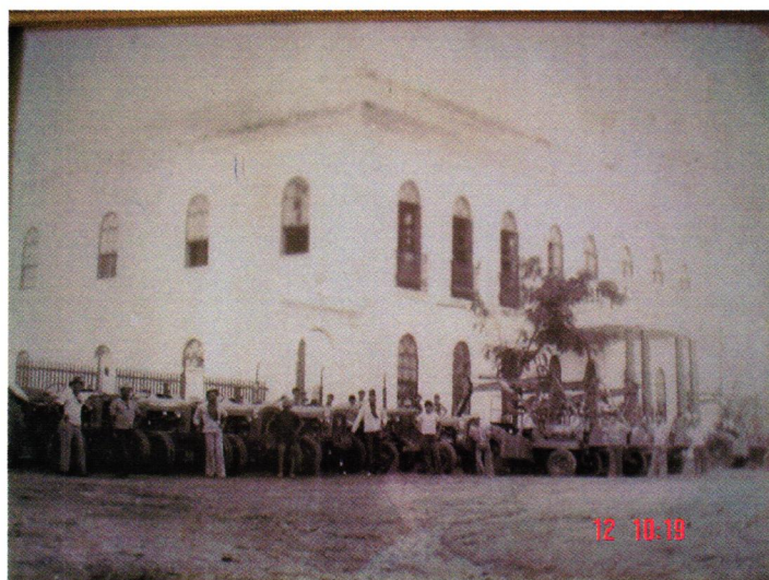
Figura 1 – Foto resgatada, mostrando os trabalhadores com os novos tratores em frente ao sobrado da fazenda. Fonte: Usina Pinheiro.
