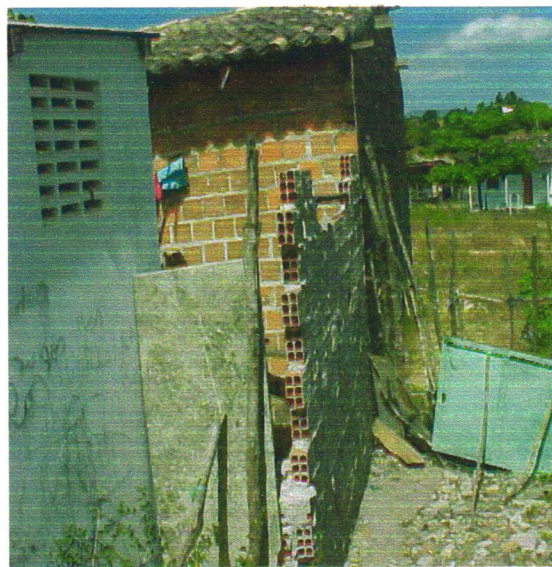
Foto 10 – Vista do muro construído pelo beneficiário com os blocos do sumidouro (Foto 09) .
