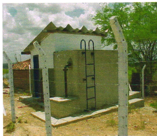
Foto 04 – Vista da Estação Elevatória.
