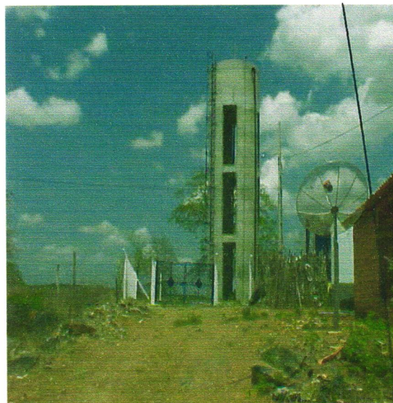
Foto 02 – Reservatório Elevado – Cap. 30 m3
