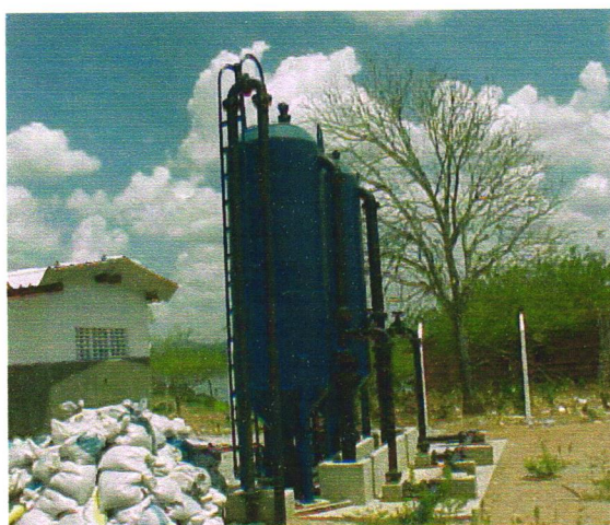
Foto 03 –Filtros de Fluxo Ascendente – ETA (na fase de execução).
