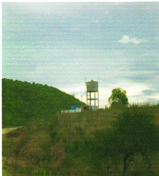
Foto 01 – Vista da estação de tratamento de água – ETA na localidade de Niterói
