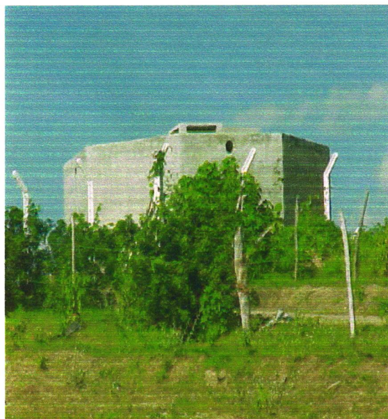
Foto 03 – Vista do reservatório apoiado com cap. 75 m3 no acesso a localidade Mocambo.
