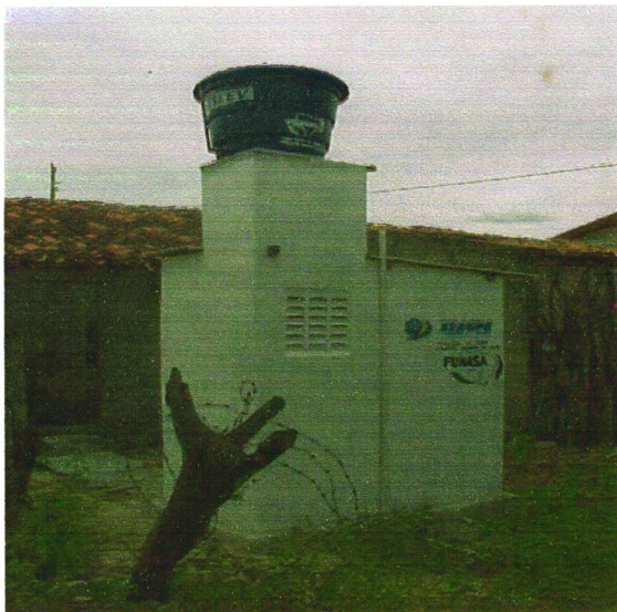
Foto 05 – Vista de um banheiro na zona rural que dispõe de abastecimento de água em Porto da Folha (na época da entrega ao beneficiário).
