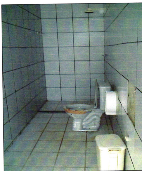
Figura 50 - Banheiro de um posto de combustível.
