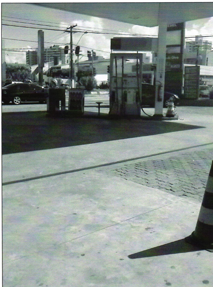
Figura 24 - Piso industrial na área de abastecimento e paralelepípedo na pista de rolamento.
