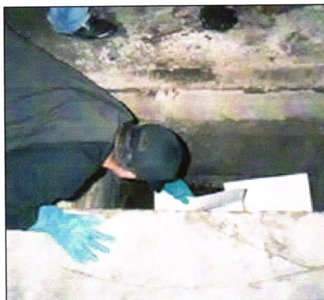
Figura 11 - Aplicação de mantas oleofílicas em caixa de inspeção de águas pluviais.
