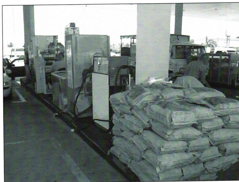
Figura 42 - Depósito irregular de sacos de carvão dentro da Zona 2 (unidade abastecedora).
