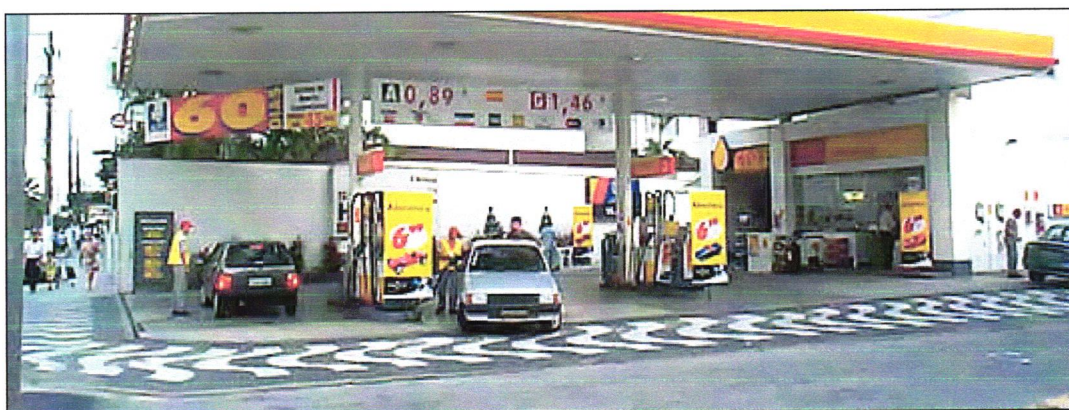
Figura 1 - Vista geral de um posto de abastecimento.
