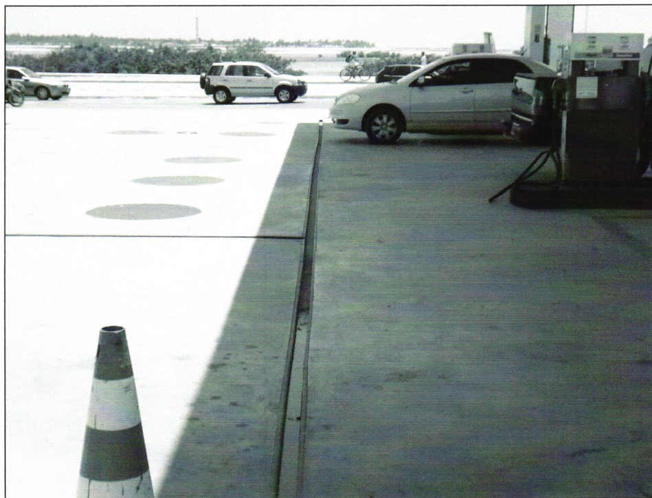
Figura 25 - Canaletas de drenagem.
