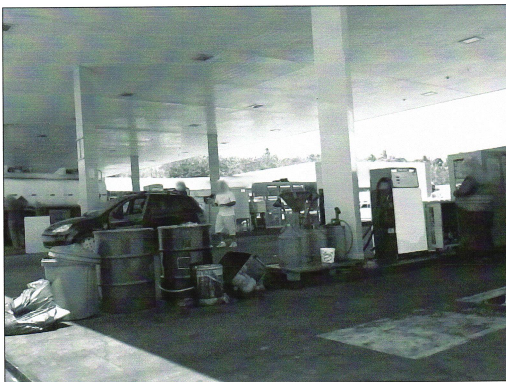
Figura 27 – Acondicionamento inadequado de resíduos sólidos.
