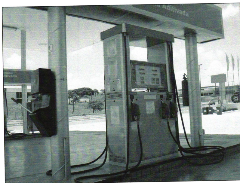
Figura 48 - Limpeza e organização do posto de abastecimento.
