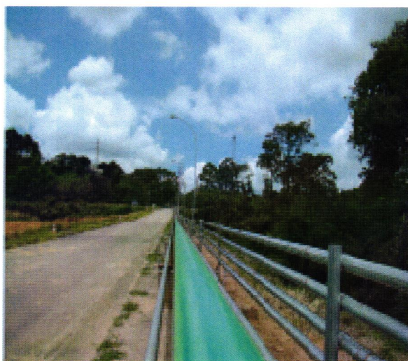
Avenida 10 com os postes re-locados ao lado direito e a tubulação aparente em estágio avançado de conclusão.
