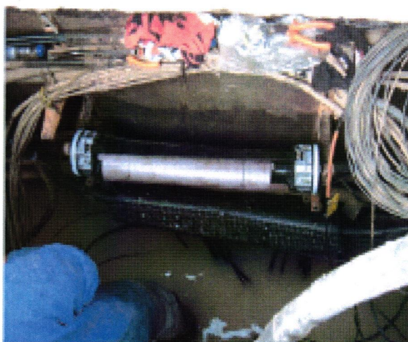
Organização de trabalho no momento da conectorização do cabo telefônico.
