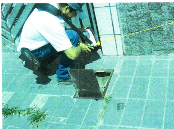
Figura 05: Leitura em caixa no piso
