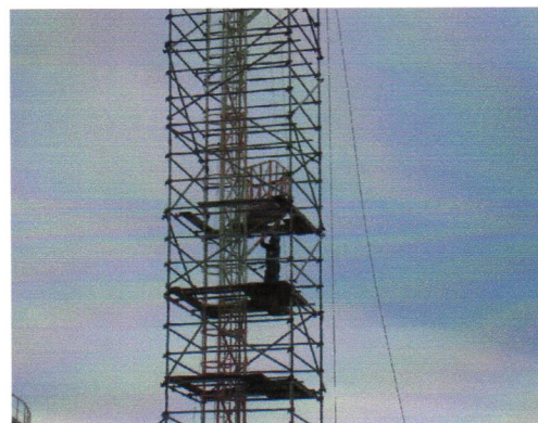
Figura 24 – Andaime em torre Fonte: Empresa Petrolífera, 2008
