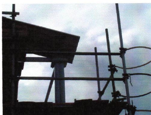
Figura 25 - Escada e guarda-corpo Fonte: Empresa Petrolífera, 2008
