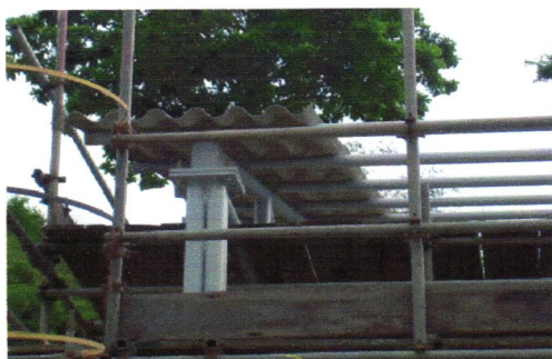
Figura 36 – Exemplos de Andaimos usados na empresa
