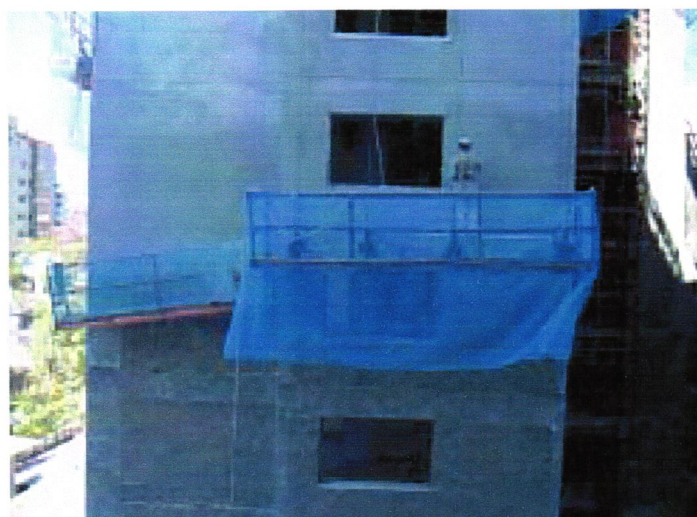
Figura 19 – Vista frontal de um andaime leve (à esquerda) e de um pesado (à direita).
