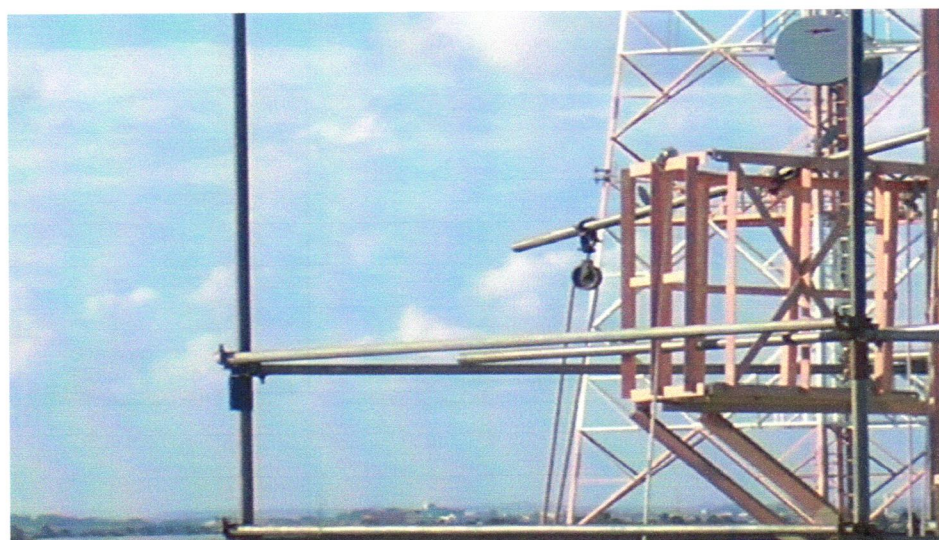
Figura 27 – Exemplo de Roldana
