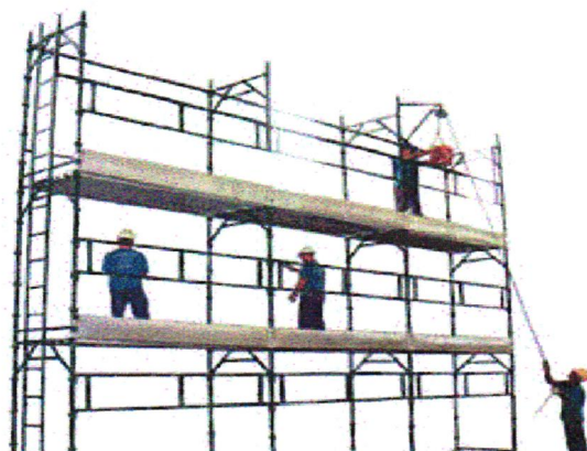
Figura 16 – Andaime do tipo fachadeiro
