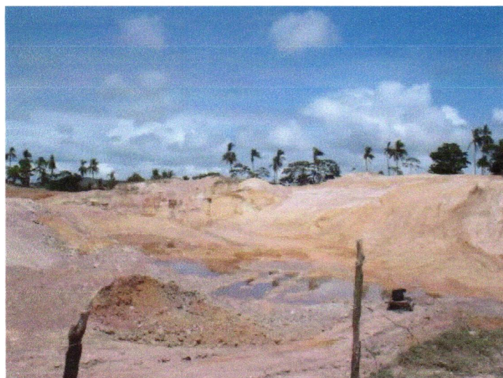
Foto 12 - Acumulo de Água de Chuva e Chorume no Aterro, em 2006. (Foto das Autoras)
