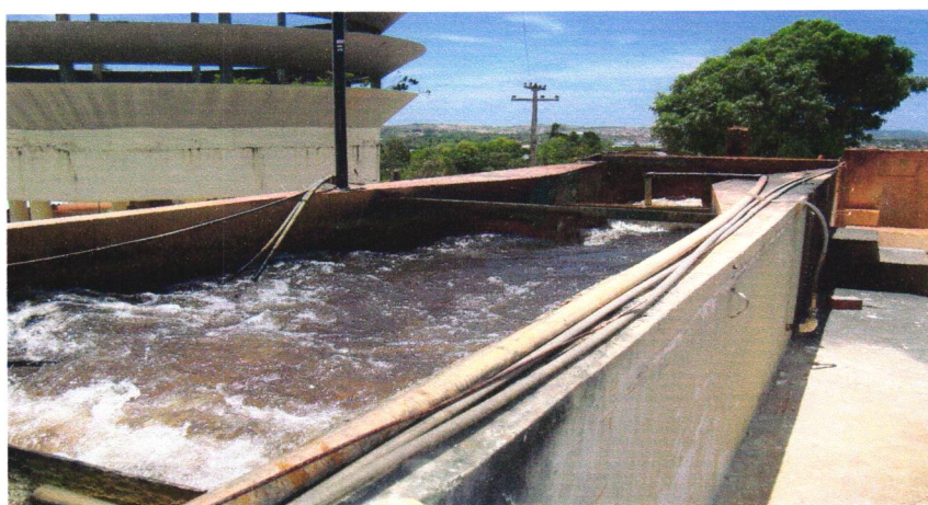
Figura 4: Calha Parshall da ETA Poxim.
