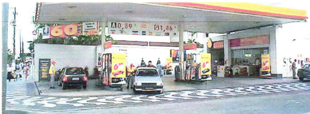
Foto 1 – Posto Padrão (instalado em terra para atendimento de veículos)
