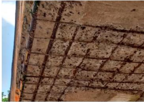
Figura 05 – Corrosão
