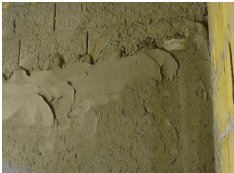
Figura 2 - Aplicação do emboço.
