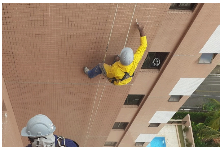
Figura 23 - Processo de escarificação em altura.
