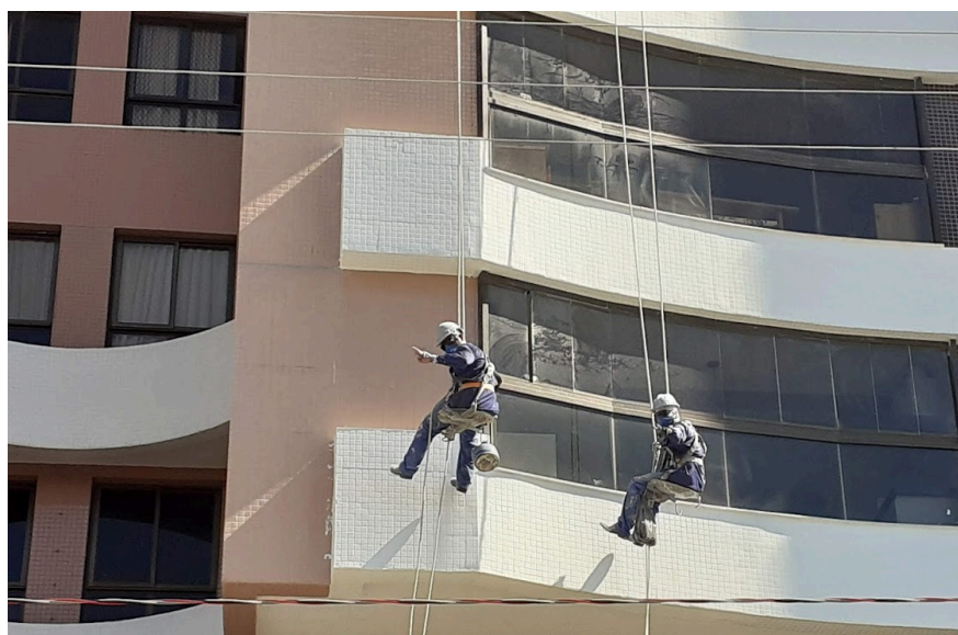
Figura 19 - Trabalhadores executando serviço em altura.
