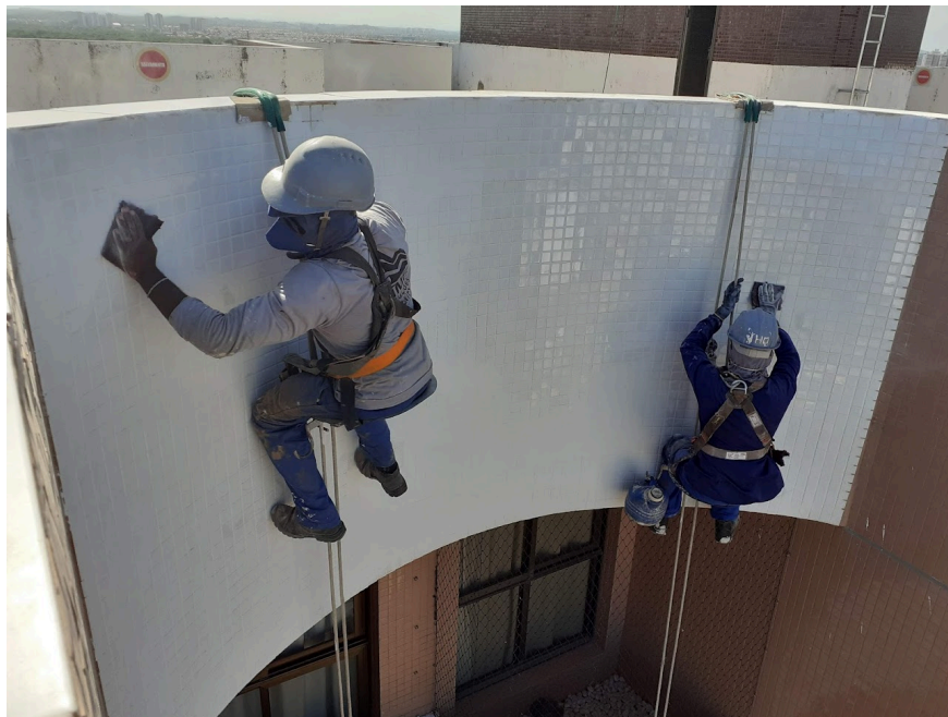
Figura 28 - Limpeza do excesso de rejunte.
