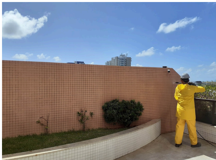
Figura 22 - Hidrojateamento.
