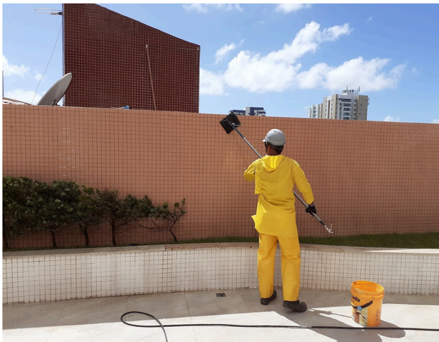
Figura 29 - Aplicação de impermeabilizante.
