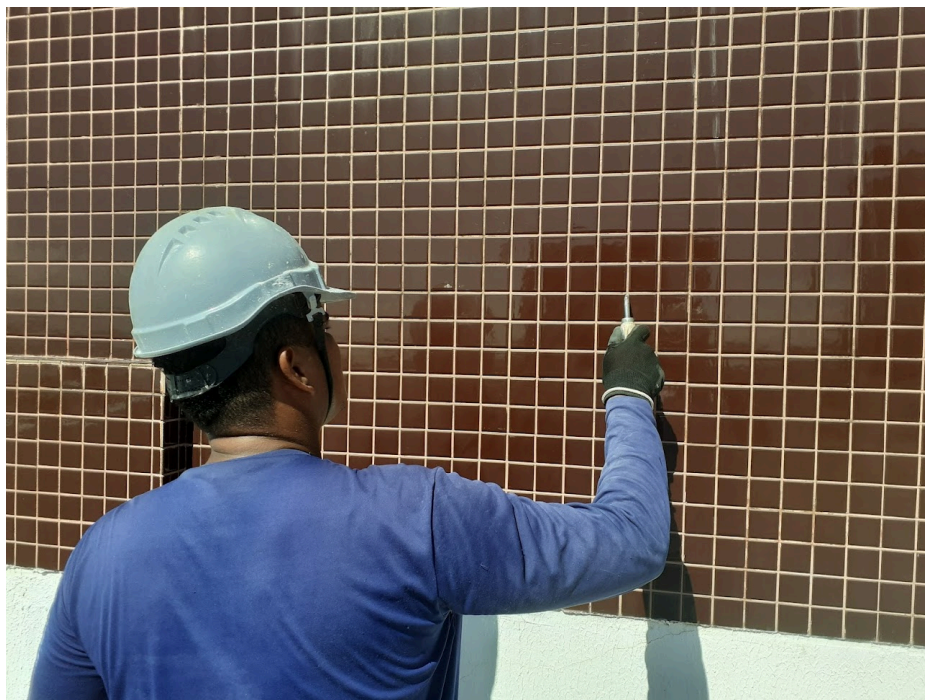
Figura 24 - Processo de escarificação.
