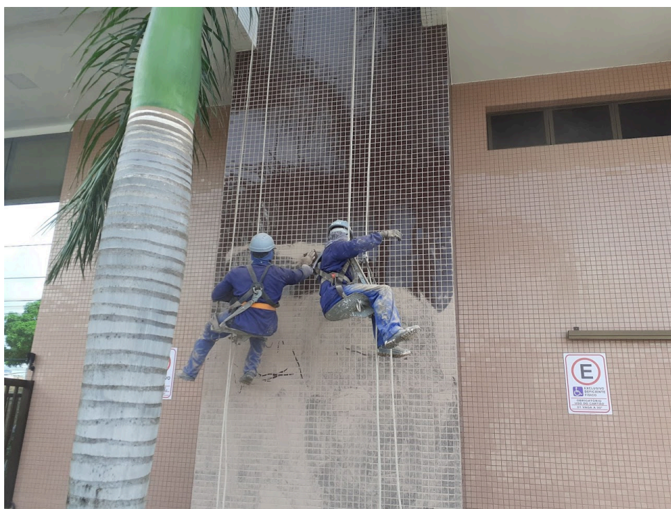
Figura 27 - Limpeza do excesso de rejunte.
