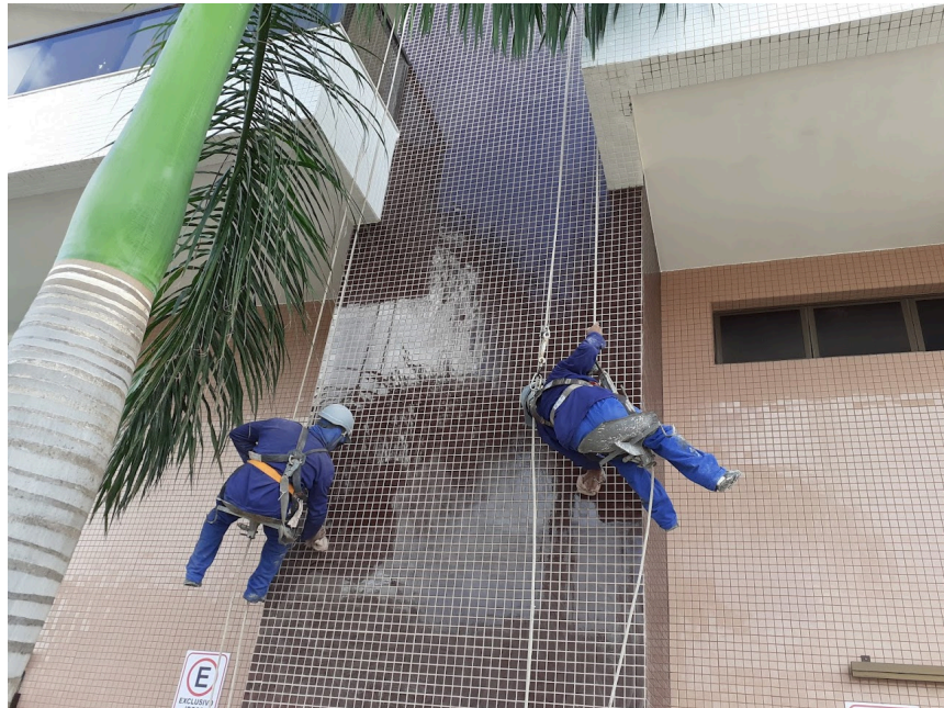
Figura 30 - Processo de polimento.
