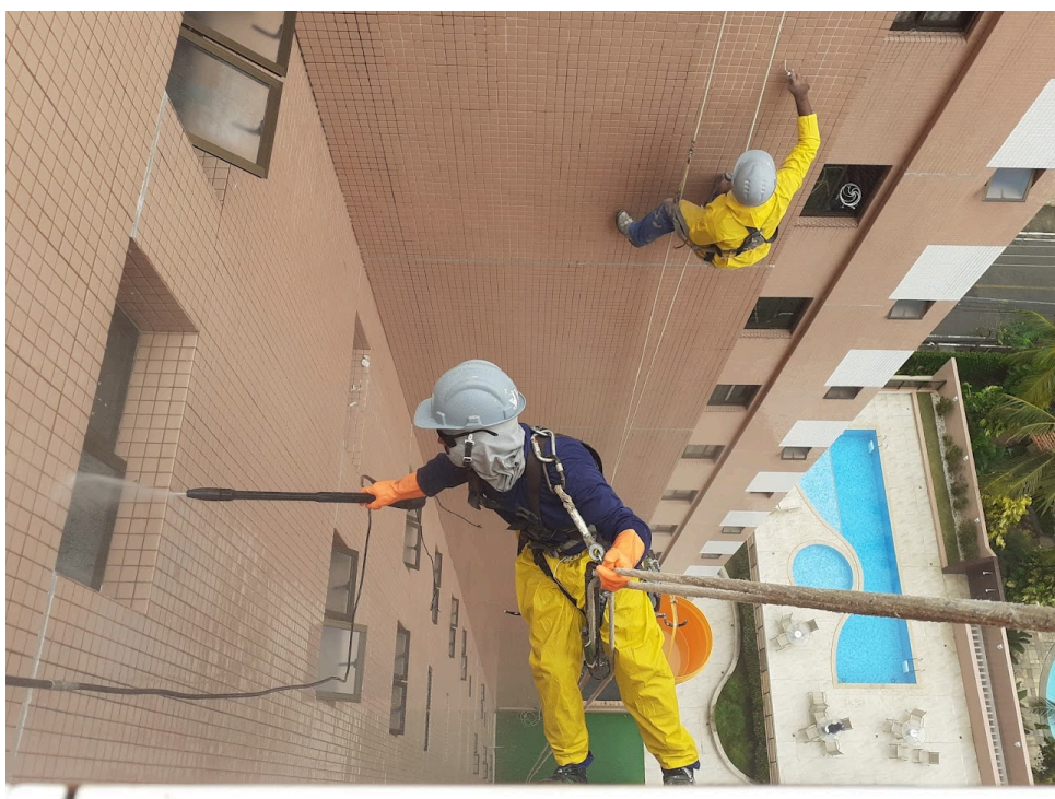
Figura 21 - Hidrojateamento.
