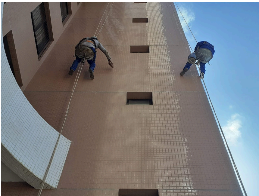
Figura 31 - Processo de polimento.
