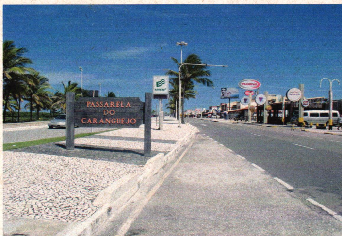
Figura 6 – Passarela do Caranguejo – vista geral
