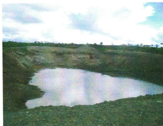
Foto 6 – Vala aberta para implantar a lagoa facultativa. Fonte: Autor, 2009.
