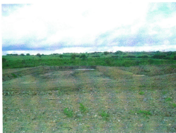
Foto 5 – Vala para construção da Lagoa Anaeróbica. Fonte: Autor, 2009.
