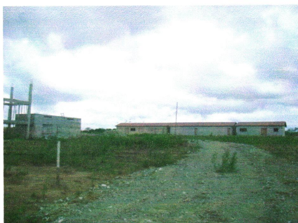
Foto 1 – Vista parcial da obra do Matadouro Regional. Fonte: Autor, 2009.
