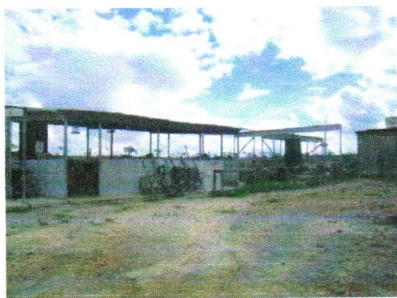
Foto 3 – Canteiro de obra para a construção do matadouro. Fonte: Autor, 2009.
