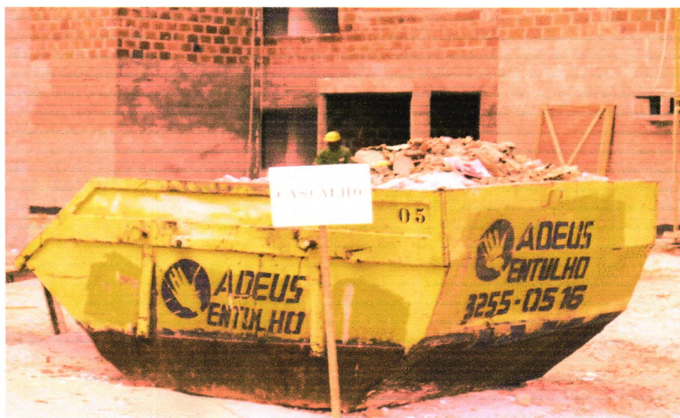
Figura 8: Contêiner com cascalho
