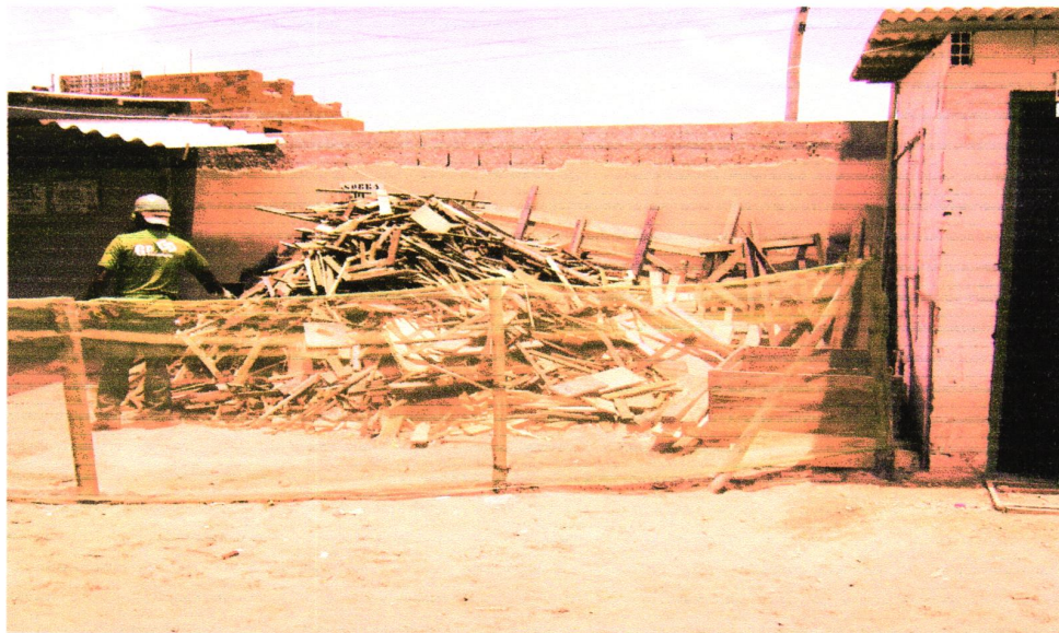
Figura 5: Separação das madeiras
