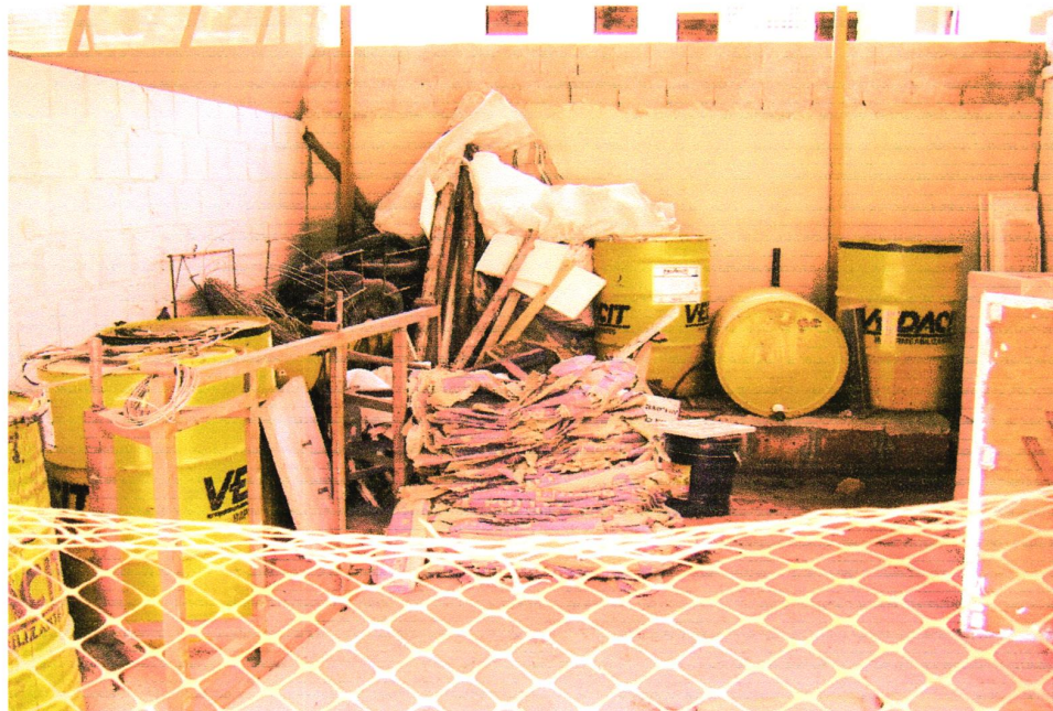
Figura 4: armazenamento dos sacos de cimento
