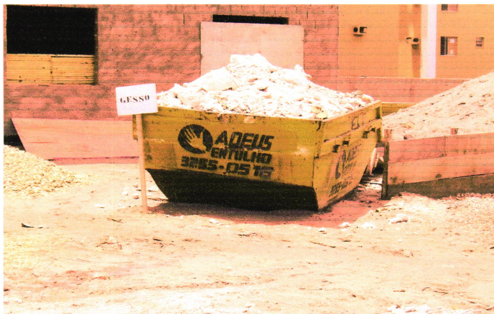
Figura 7: Contêiner com gesso
