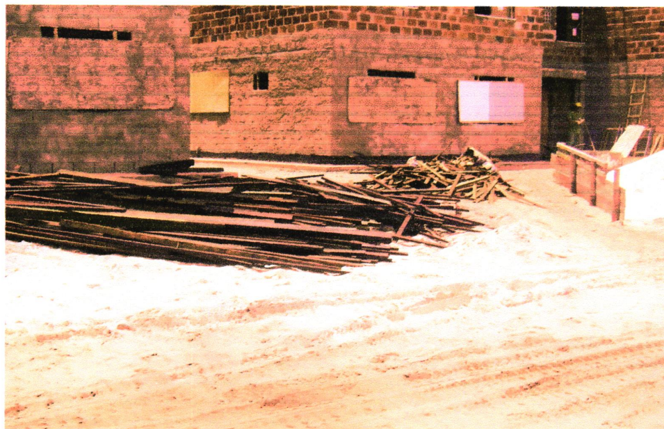
Figura 6: Separação da madeira
