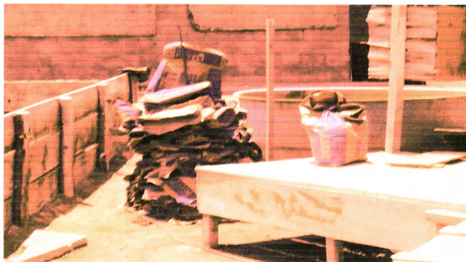
Figura 3: separação dos sacos de cimento
