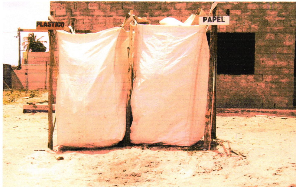
Figura 2: Baias separando o papel e plástico
