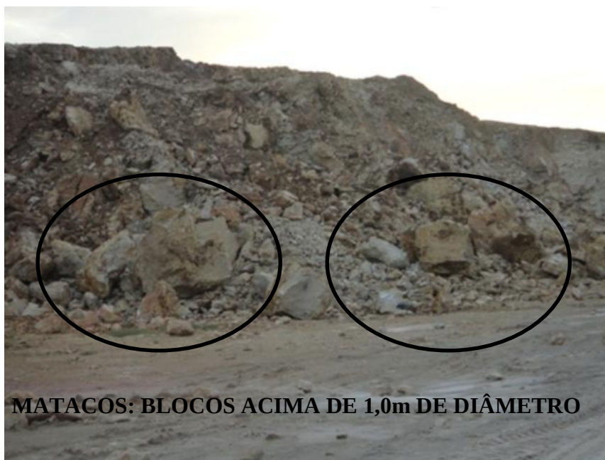
Figura 24 – Mataco provocado por tampão inadequado.
