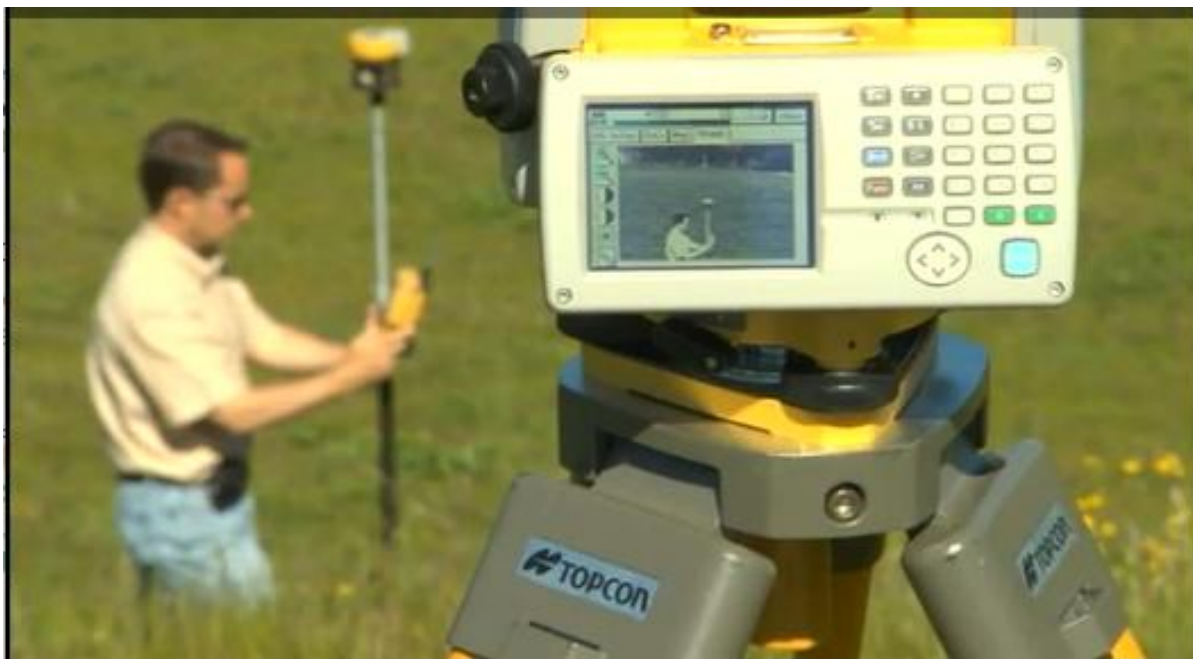
Figura 18 – Nivelamento dos furos
