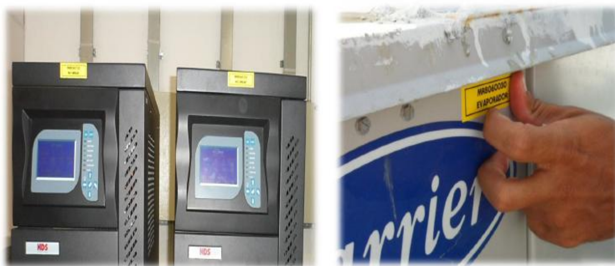
Figura 22 – Tagueamento dos Equipamentos
