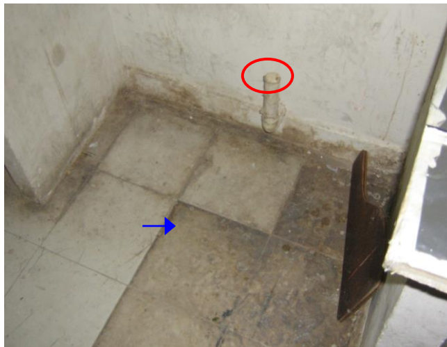
Figura 10 – local destinado a descanso e refeições dos funcionários.
