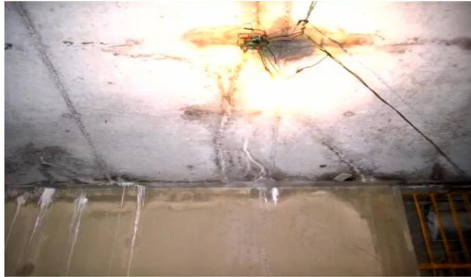
Figura 06 – Infiltrações e rachaduras na laje - Documentário caos no cárcere
