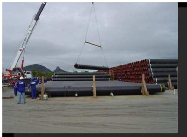
**Figura 19 - Utilização de guindastes para elevação da carga**
