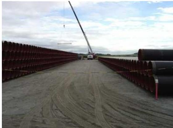
**Figura 20 - Armazenagem de tubos**
