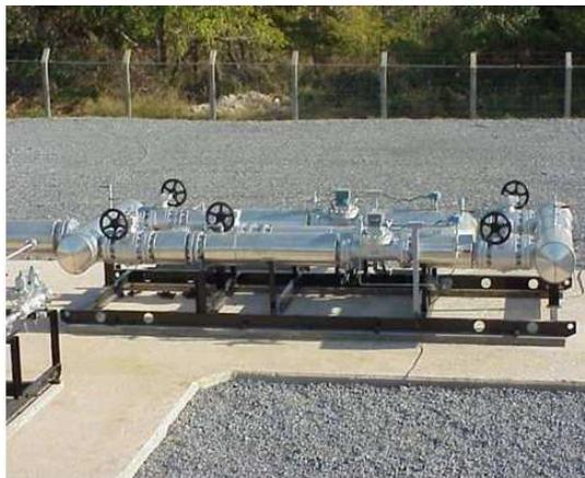
**Figura 15 - Válvula de bloqueio**
