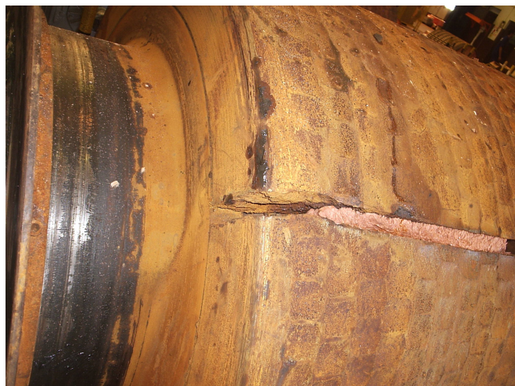
Foto 11 - Anel de moldagem fraturado.
