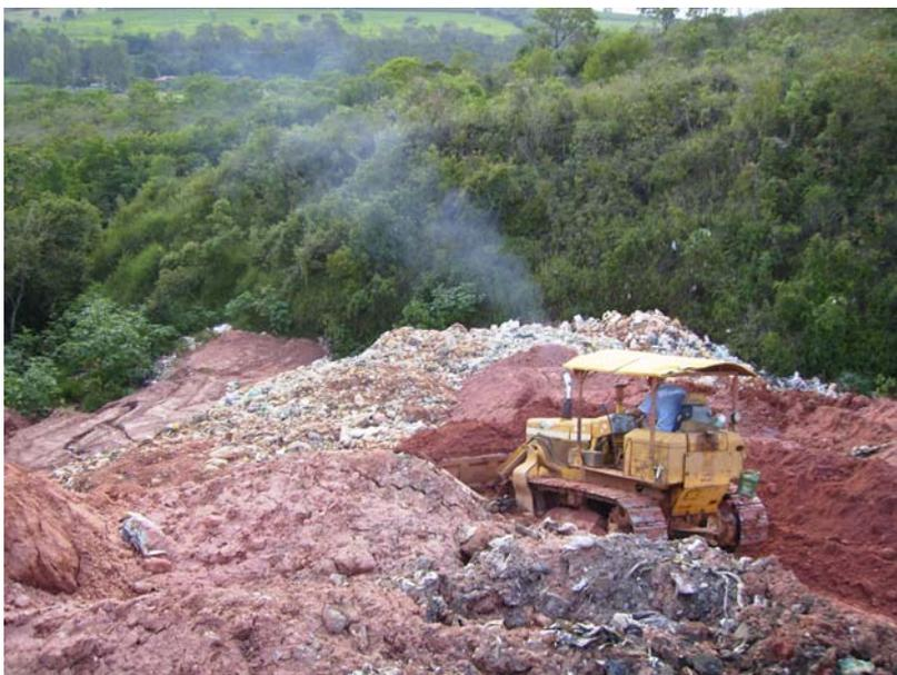
**Figura 08 – Processo de cobertura com terra em um aterro controlado**
