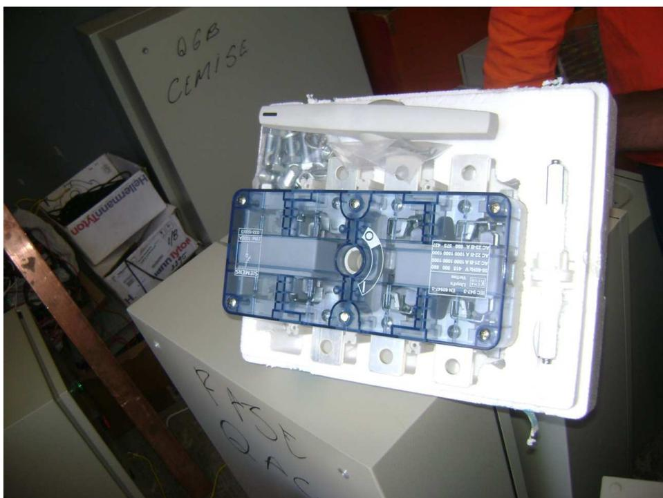
Figura 22 – Chave Geral ou Manual do Banco de Capacitores
